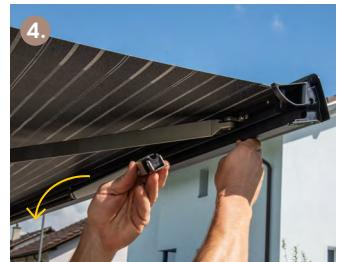
Anschliessend die Stützbeine aus der Halterung nehmen und nach unten klappen.
